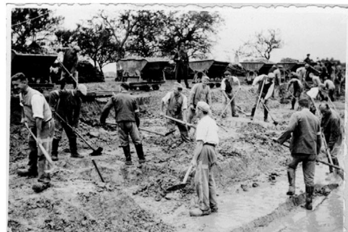
Arbeiten am Flussbett der Gersprenz bei Münster-Wiesenmühle
